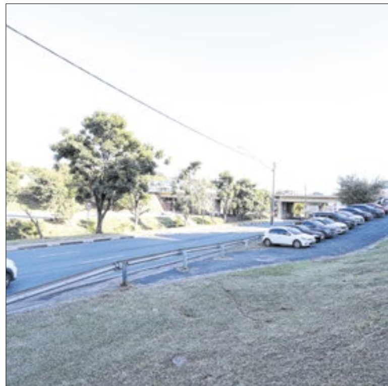
Acesso será construído em terreno de cerca de 280 metros quadrados
