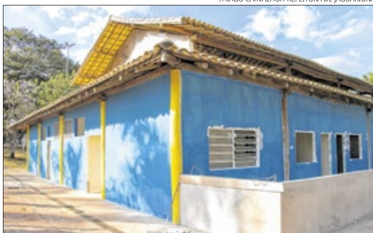
Unidade escolar terá área total de 2.761 m² mais 600 m² de construção
