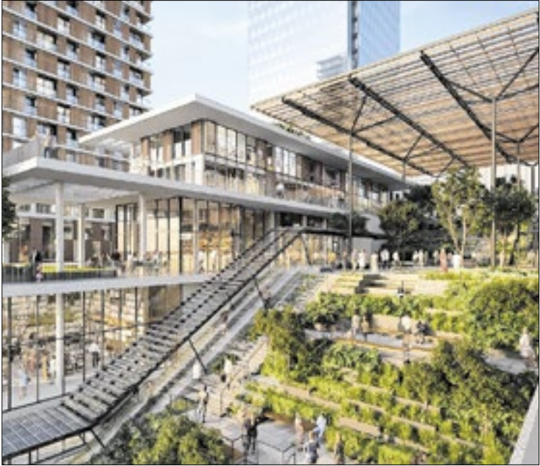
Casa Figueira compreende edificações e infraestrutura urbana
