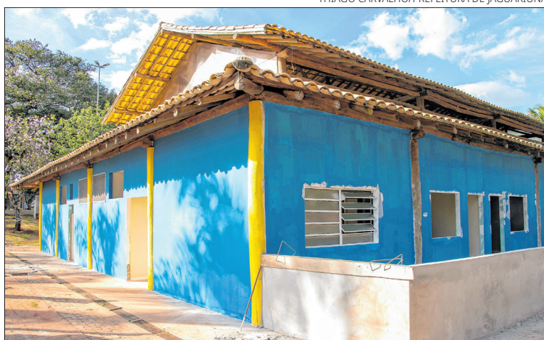
Unidade escolar terá área total de 2.761 m2 mais 600 m2 de construção
