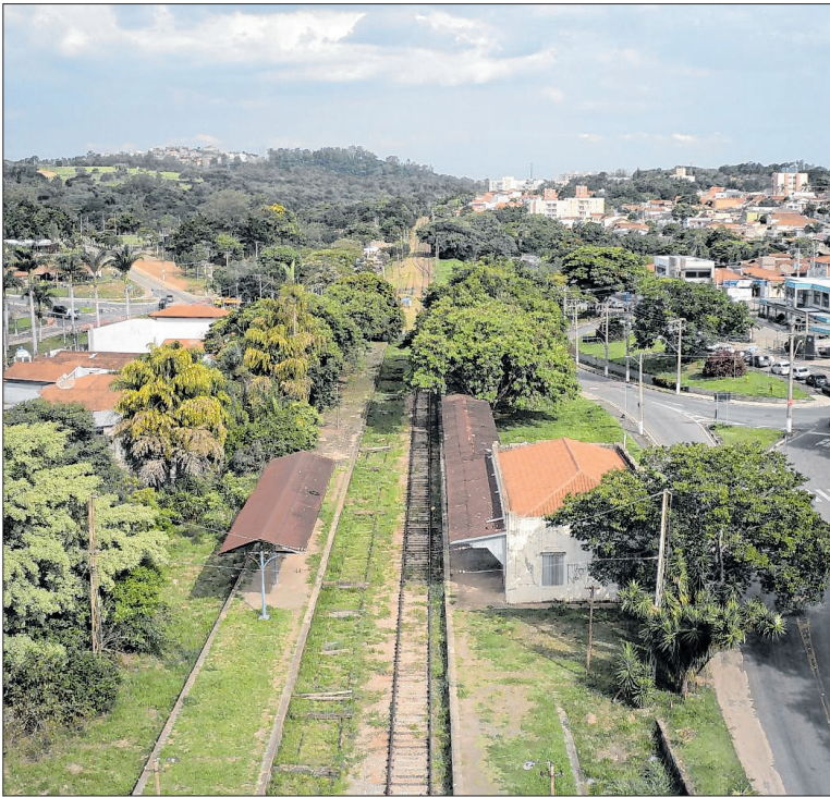
Comissão acompanhará a execução das obras do TIC e do TIM em Vinhedo
