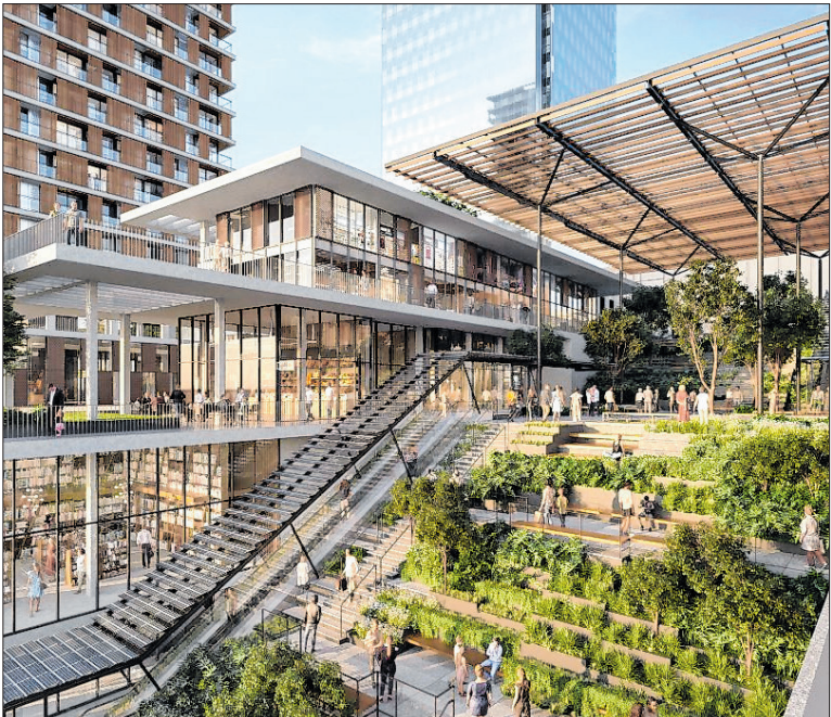
Casa Figueira compreende edificações e infraestrutura urbana
