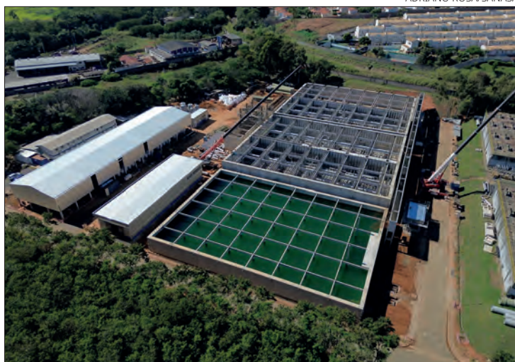
Conversão da Estação de Tratamento de Esgoto em EPAR Anhumas
