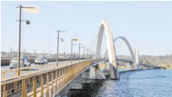
Trecho liga a Estrada Parque das Nações (DF-004) à Ponte JK
