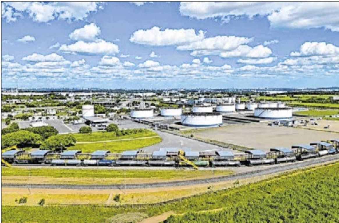
Com novo tanque de 20 mil metros cúbicos, o terminal amplia a eficiência no armazenamento e na distribuição de combustíveis
