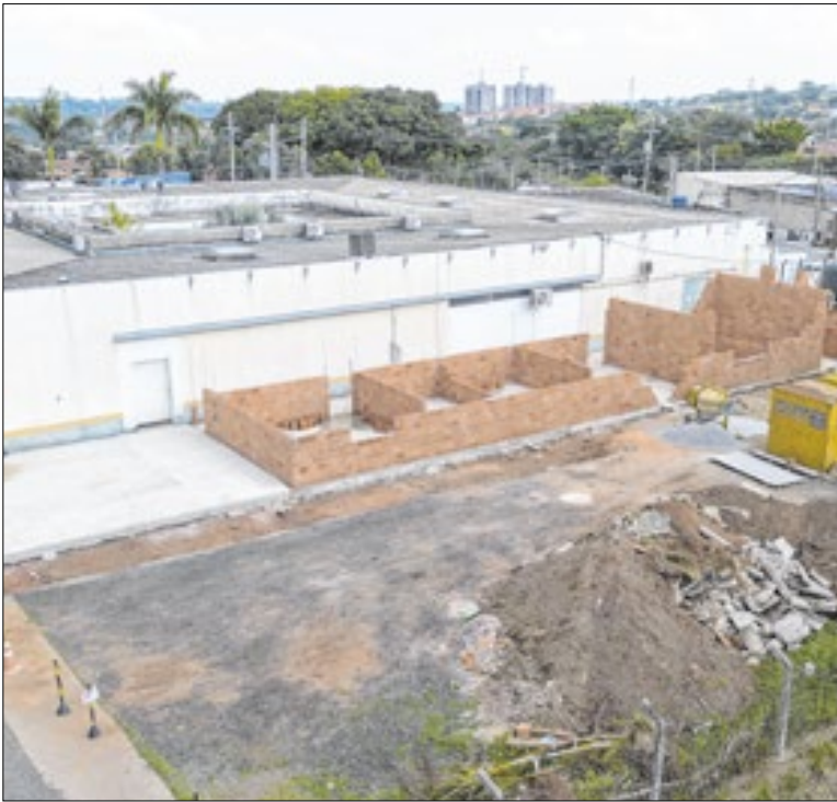
A unidade 60+ funcionará integrada à UPA e as obras já estão em andamento
