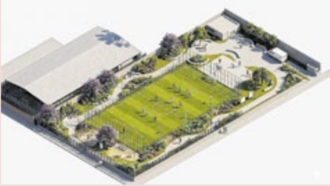
Obra está na fase de preparação antes do gramado sintético
