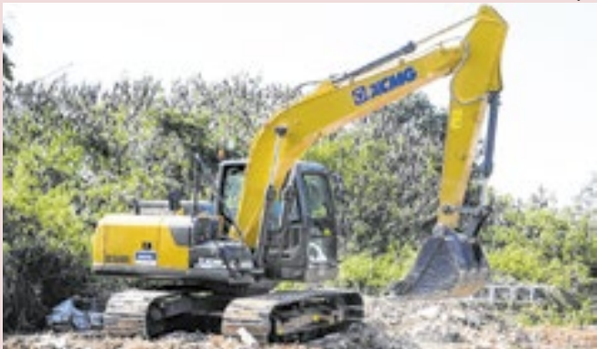
Retroescavadeira e triciclo passam a integrar a estrutura
