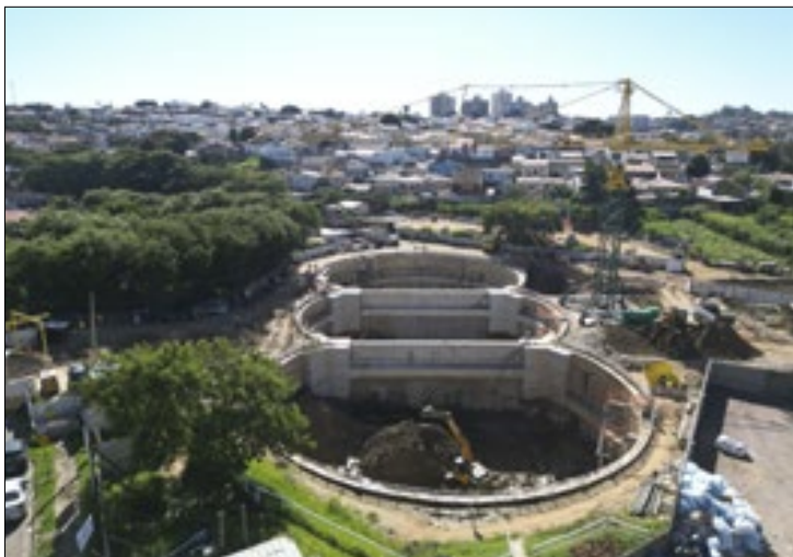
Reservatório RP-1 terá capacidade para 120 milhões de litros de água
