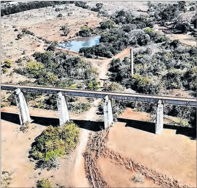
Jovem morreu após queda de cerca de 30 metros na Ponte do Esqueleto, em Limeira
