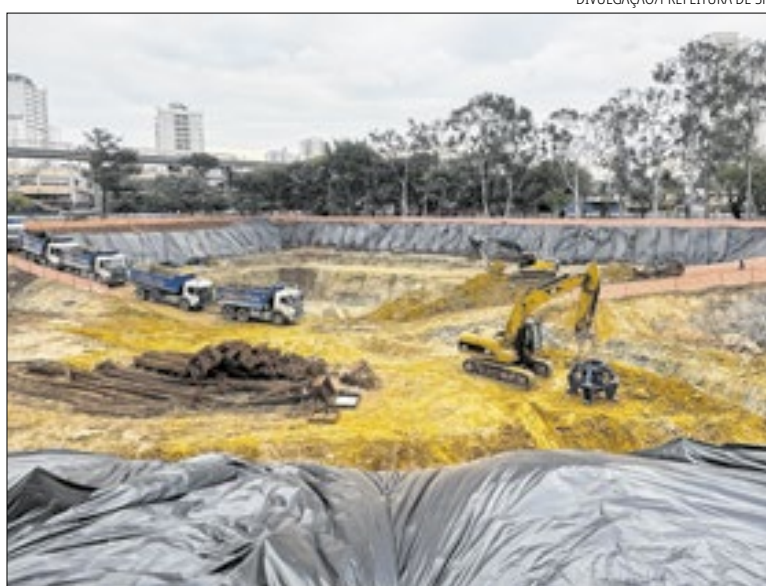
Obras do novo reservatório do córrego da Mooca, Av. Anhaia Mello, na Zona Leste
