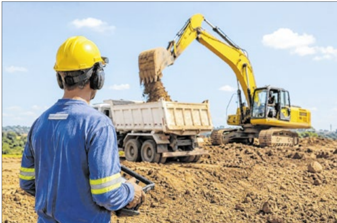
Entre os principais resultados estão a fabricação de máquinas e equipamentos para terraplenagem, pavimentação e construção
