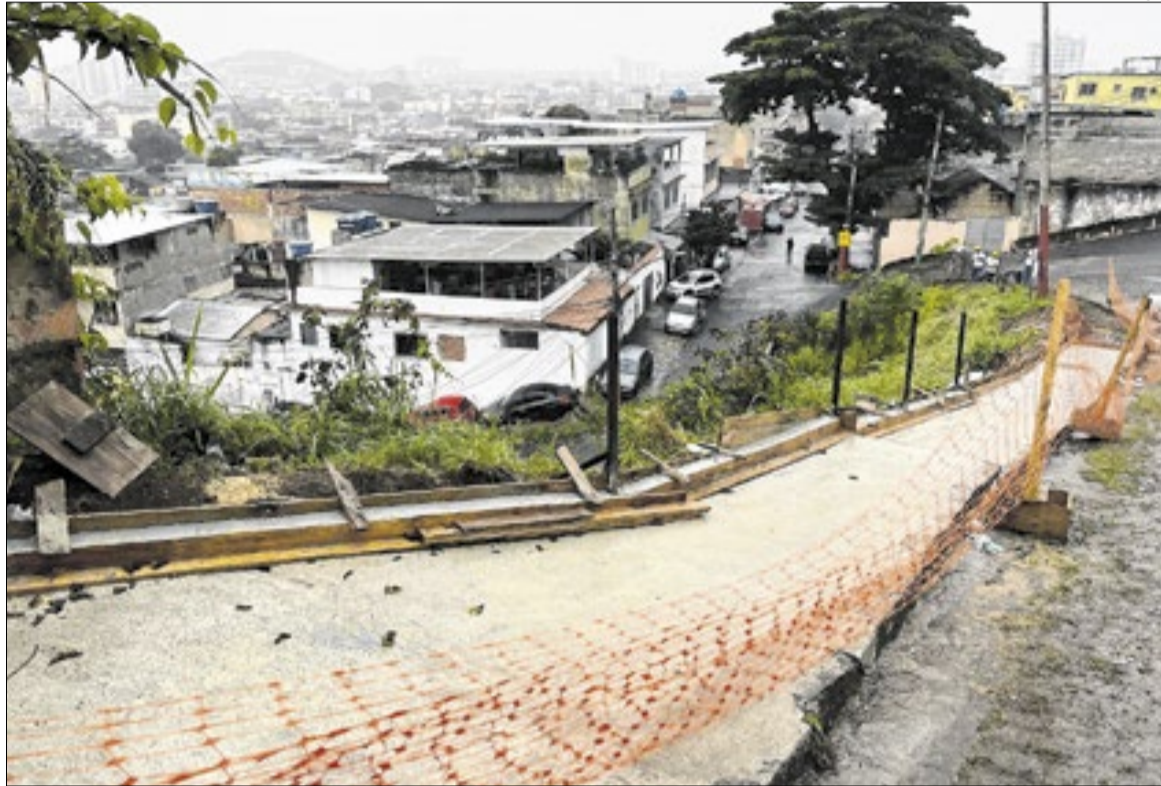
Intervenções incluem recuperação de escadaria, construção de calçadas e instalação de guarda-corpos
