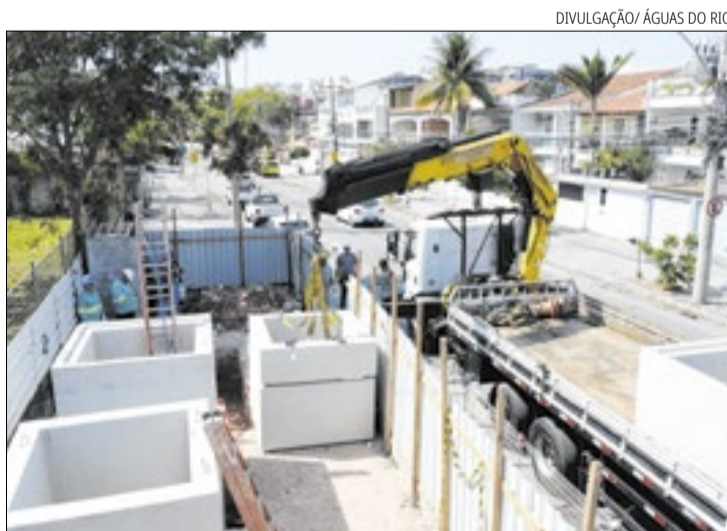
Estrutura impedirá que 490 mil litros de esgoto cheguem à Baía de Guanabara
