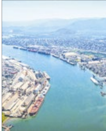
Túnel ligará Santos e Guarujá (SP)
