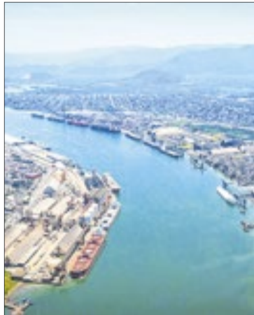
Túnel ligará Santos e Guarujá (SP)
