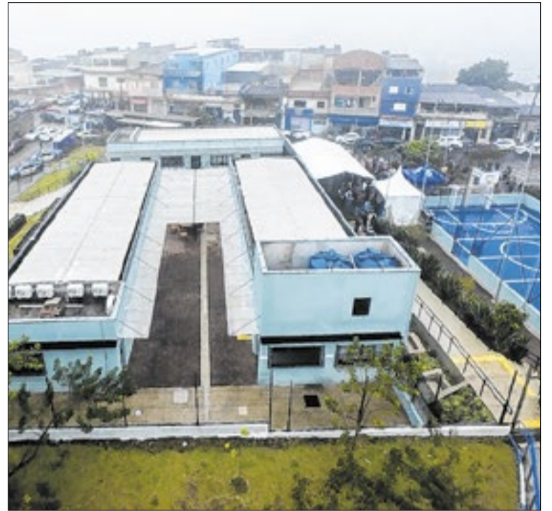
O novo equipamento ocupa uma área de 2.379,77 metros quadrados no total
