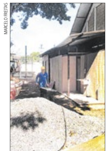
Obras de ampliação e modernização da infraestrutura
