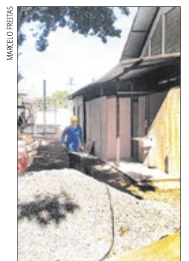
Obras de ampliação e modernização da infraestrutura
