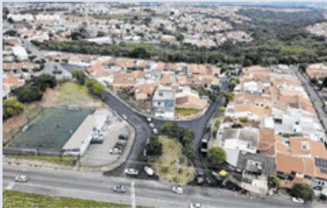
Projeto é a maior manutenção asfáltica de Americana
