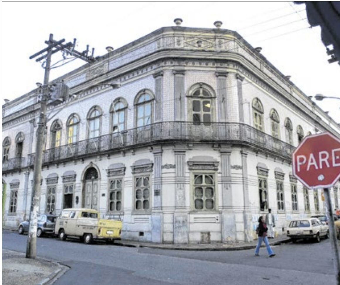
Construção foi erguida como uma demonstração de poder econômico e cultural no séc. XIX, a partir de um estilo arquitetônico neoclássico ainda raro no município naquele período
