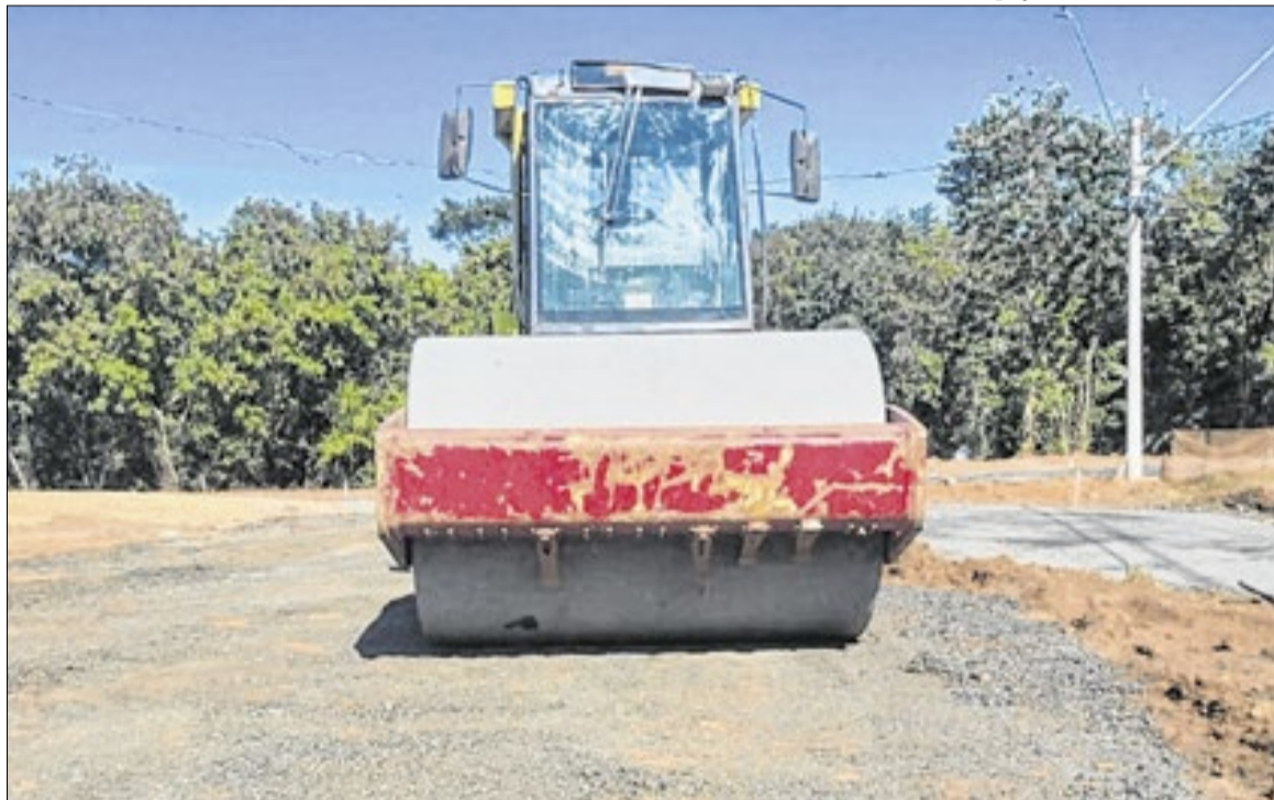
Viaduto foi projetado com acessos operacionais configurados para os dois sentidos de circulação
