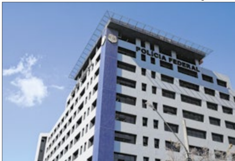
Fachada da PF - Superintendência Regional, na Lapa
