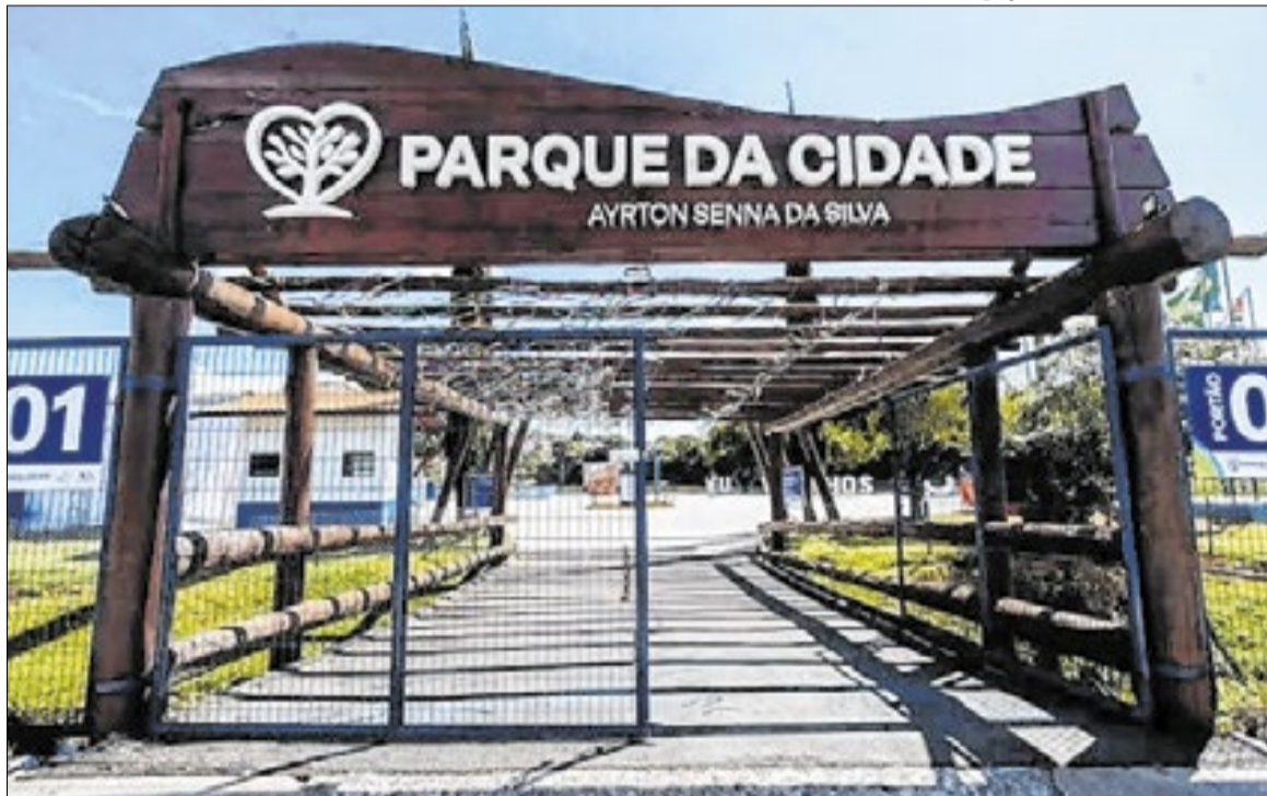
Todos os serviços serão operados pela futura concessionária e fiscalizados pelo município
