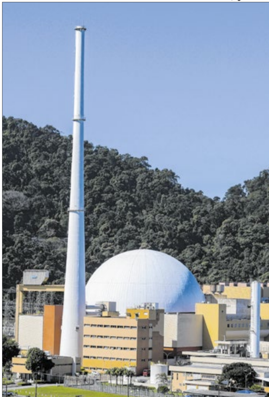
Eletronuclear opera usinas nucleares do país Angra 1 e Angra 2, na região da Costa Verde, no Rio
