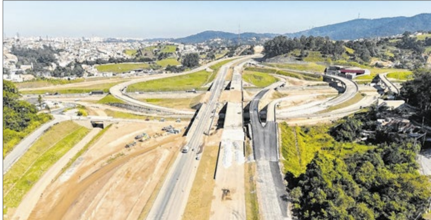
Rodoanel Norte é uma das obras do programa viário SP pra Toda Obra, lançado em 2025
