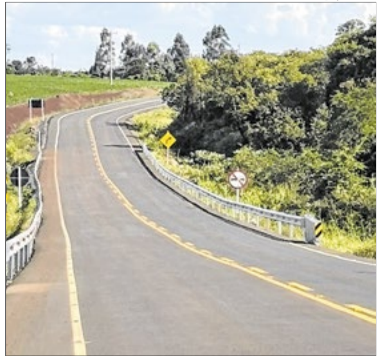
A previsão estadual é de concluir a obra ainda neste ano
