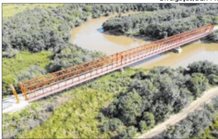
DER fará intervenção em obra neste fim de semana
