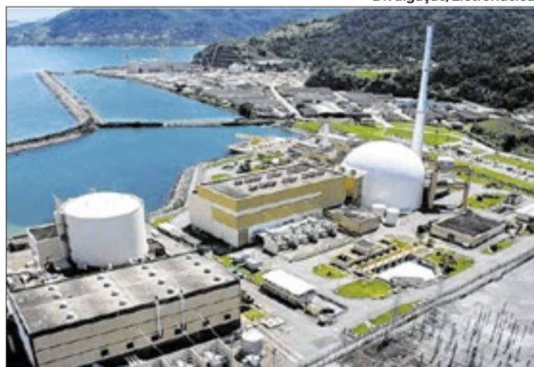
Planos visam dar continuidade às operações das usinas
