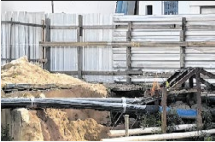
Paralisação das obras de implantação da nova ponte
