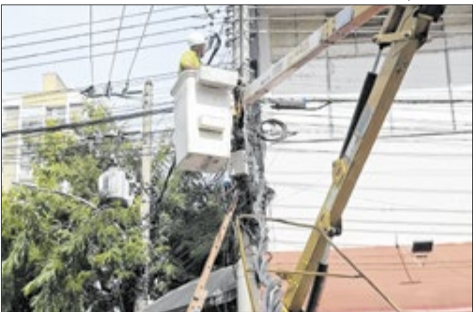
Foram substituídos e instalados 122 refletores
