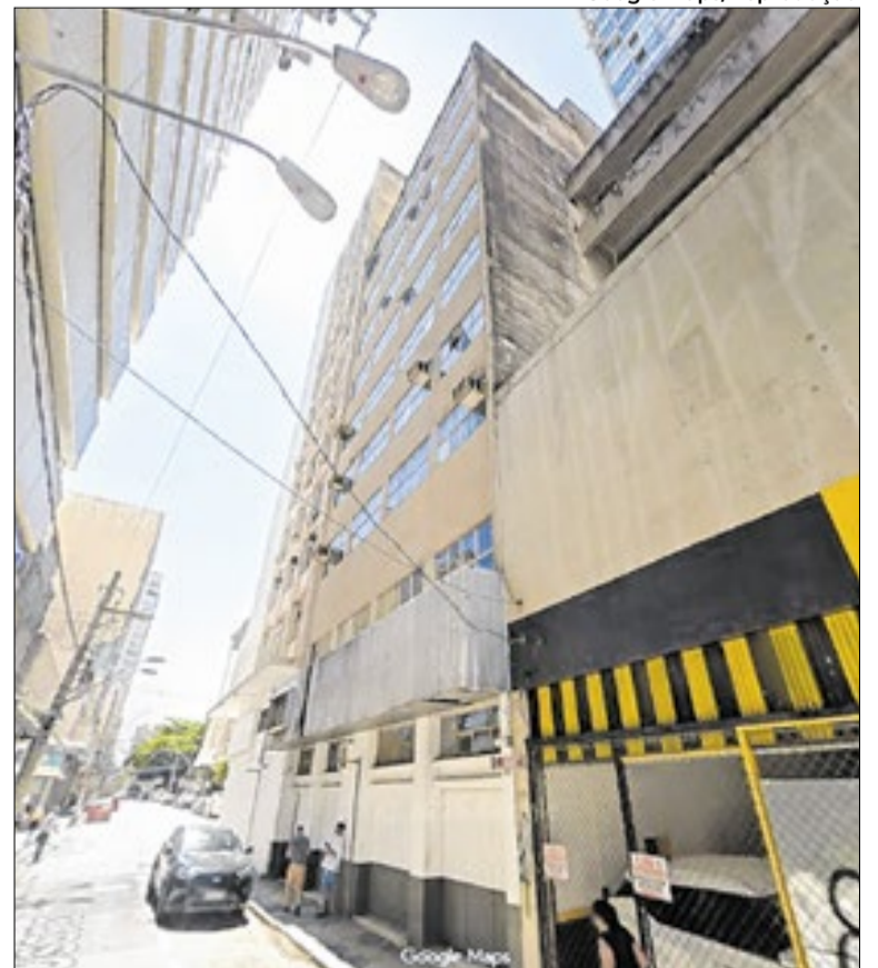
Prédio do INSS, Rua General Osório, 808, Centro de Campinas
