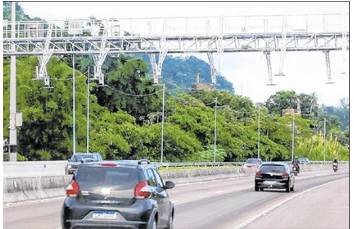
Sistema de cobrança de pedágio na Rio-Santos foi considerado falho pela própria ANTT
