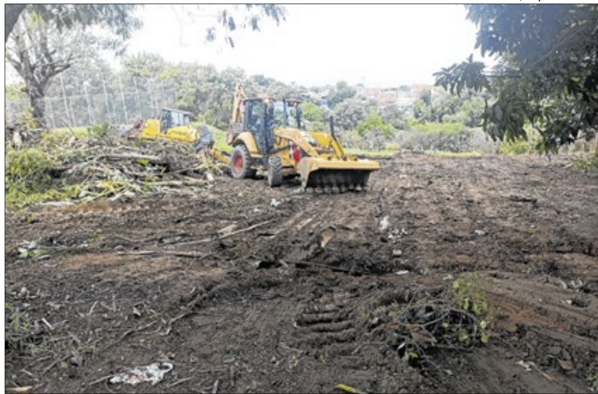
Tratores atuam em Área de Preservação Permanente no Parque Itajaí IV, em Campinas
