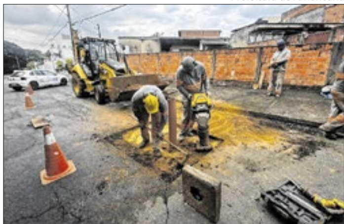
DAE faz obras para aprimorar o controle do fluxo de água
