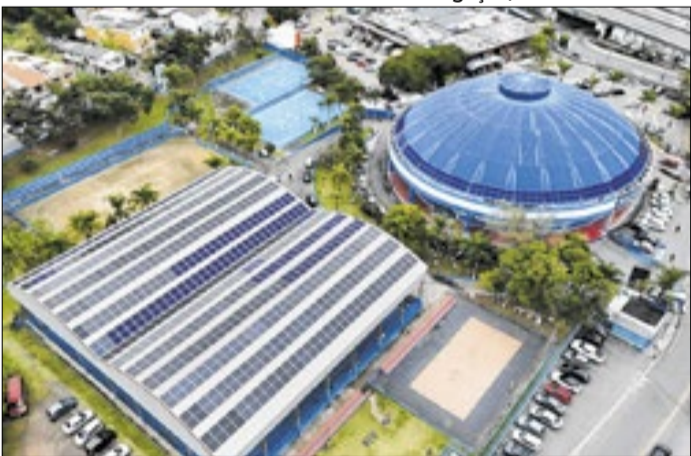
As Usinas foram instaladas no Ginásio de Esportes
