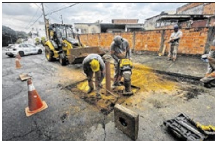
DAE faz obras para aprimorar o controle do fluxo de água
