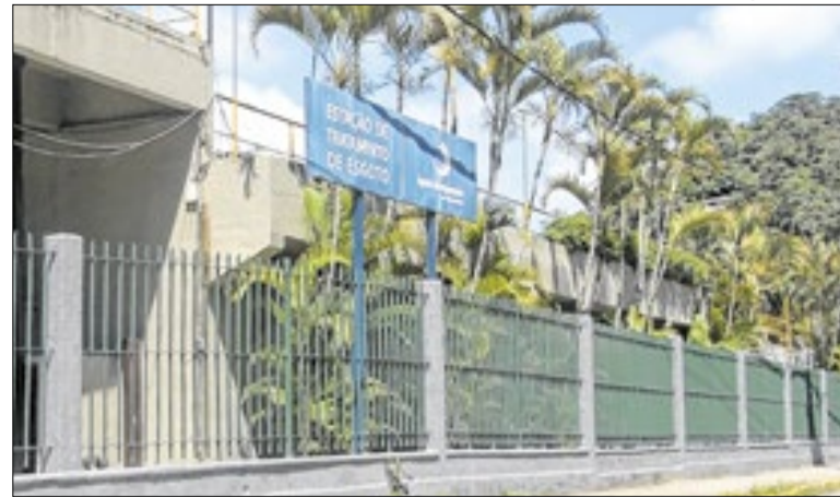
Rede de Tratamento de Esgoto da Águas do Imperador
