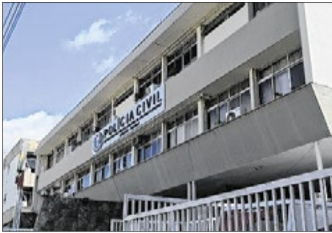
Atual sede do Deinter-2, no Centro, em Campinas
