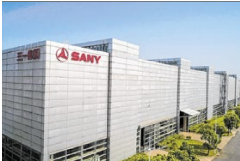
Sany vai ocupar área no Distrito Industrial, em Campinas
