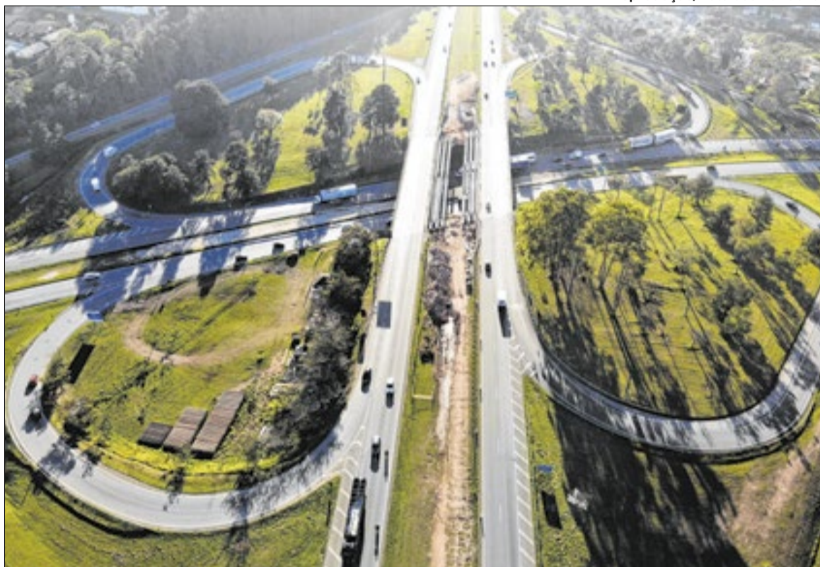
Estado recebeu estudos para implantação do Contorno Norte da Rodovia D. Pedro I
