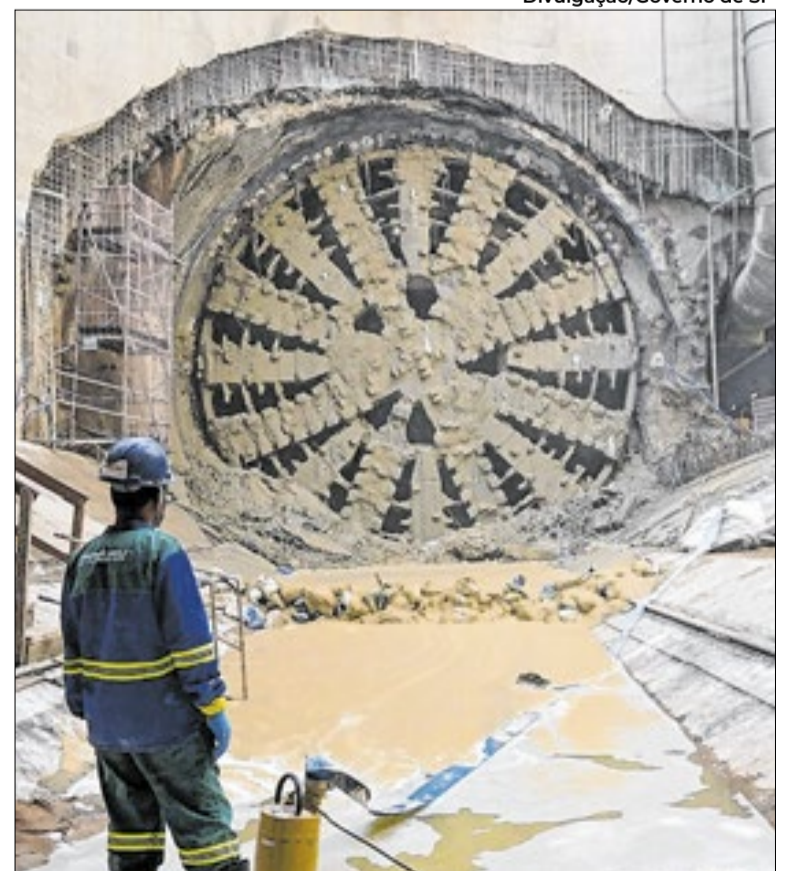
Roda de corte é a peça mais pesada da tuneladora
