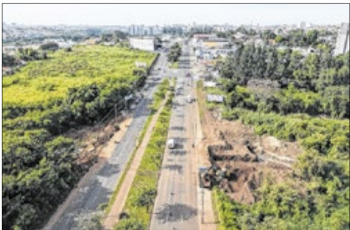
Obra busca solucionar problemas de alagamento e erosão
