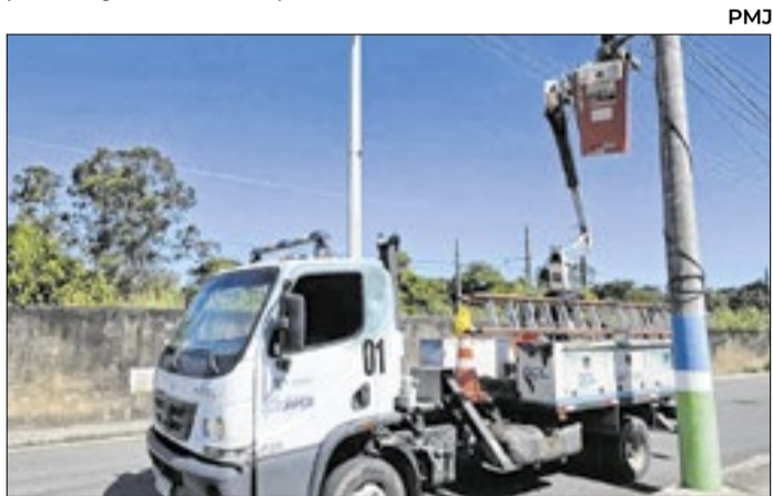
PMJ Equipes de instalação vêm atuando em dois turnos diários
