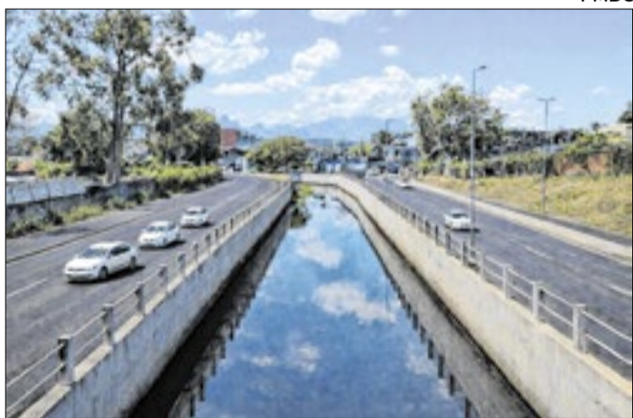
Obras de macrodrenagem ganharam destaque no painel
