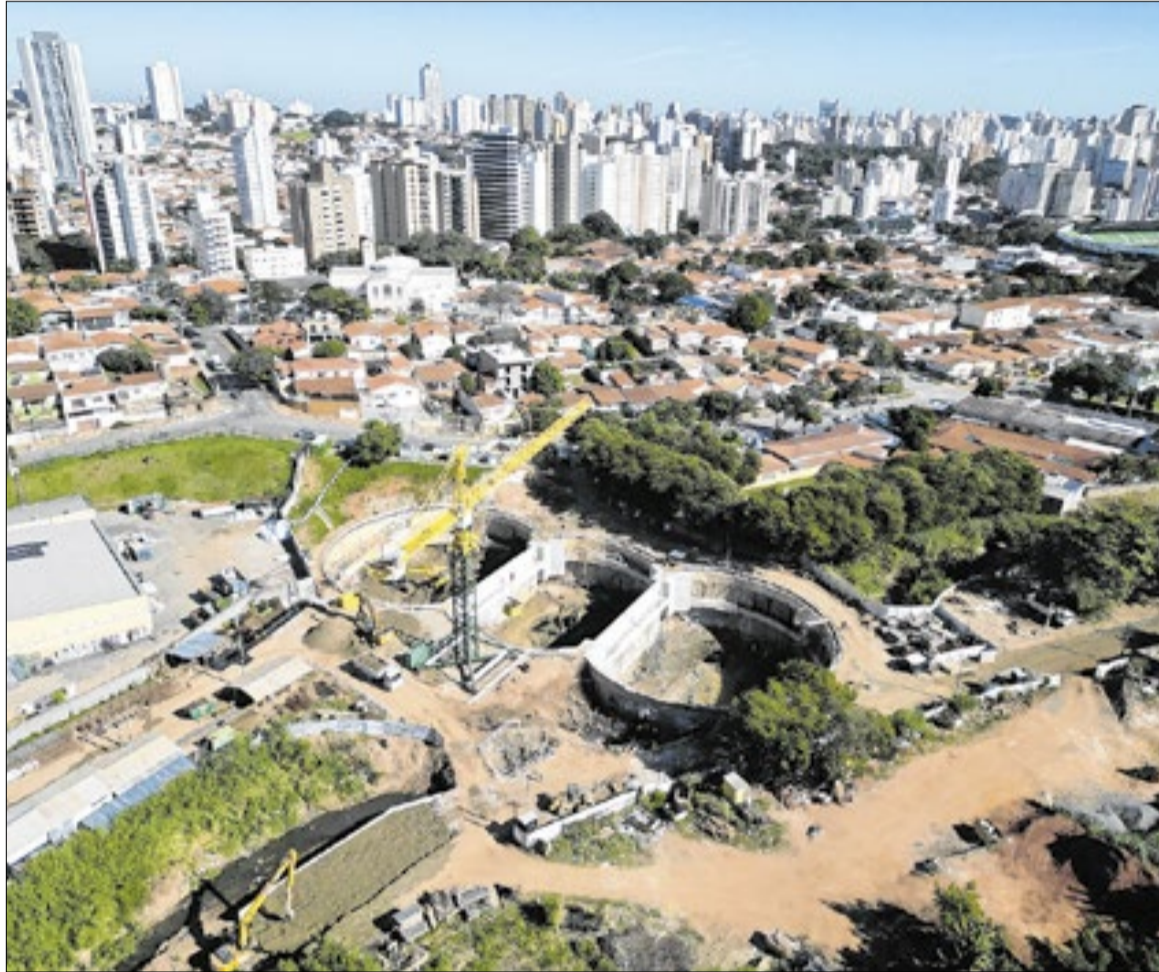
Vista aérea das obras do Reservatório RP-1, da Praça de Esportes Paranapanema
