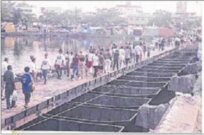
Ponte provisória construída pelo Exército, anos 1990
