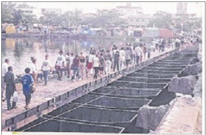
Ponte provisória construída pelo Exército, anos 1990
