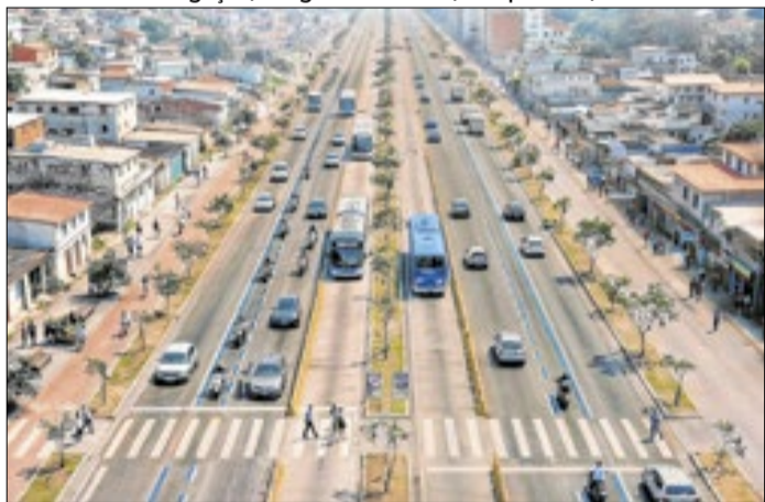
Obras do Trecho 1, com 1,2 km, devem acabar em 5 meses
