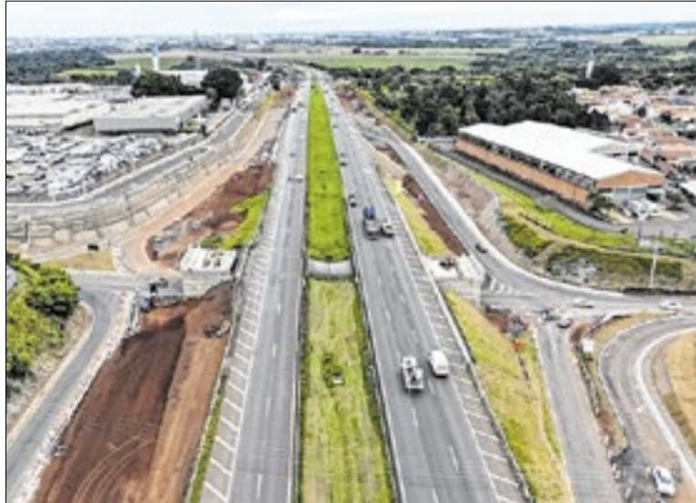
Intervenções pretendem otimizar a fluidez do tráfego
