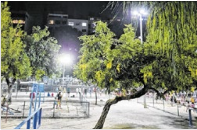
Foram instaladas 90 luminárias LED e 27 projetores.
